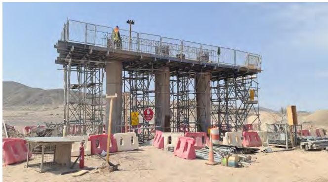
Foto N° 01 Trabajos en Enlace Acceso Sur Sierra Gorda
