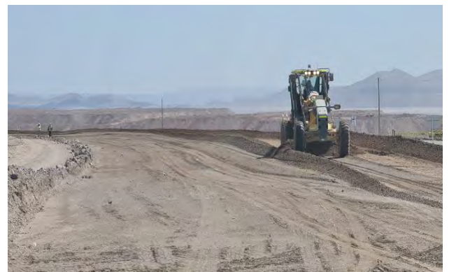
Foto N° 04 Ejecución Tercera capa formación y compactación de terraplenes
