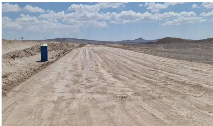
Foto N° 03 Preparación de Sellos para fundación. Instalación de Baños químicos en puntos de trabajo.
